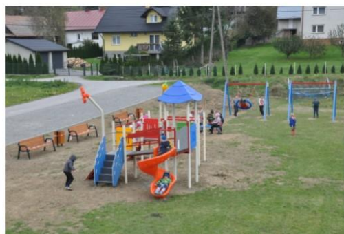
Budowa i urządzenie placu zabaw w sołectwie Białża Dolna.
