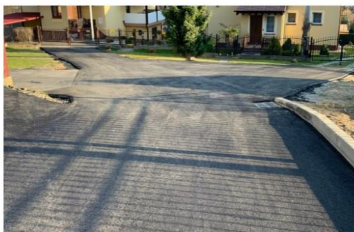
Budowa sieci kanalizacji deszczowej przy ul. Zeromskiego, Kościuszki, Witosza w Białży.
